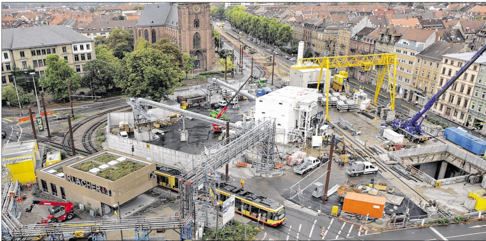
IN DAS „FABRIKTOR DER FÄCHERSTADT“ hat der U-Strab-Bau das Durlacher Tor verwandelt. Über dem Schacht in den Untergrund, wo der Tunnelbohrer startet, steht die Separieranlage (Mitte) mit Transportbändern zum Zwischenlager für den geförderten Kies – dazu rechts der Montagekran mit Tübbinglager und dahinter die Werkstatthalle. Foto: jodo
